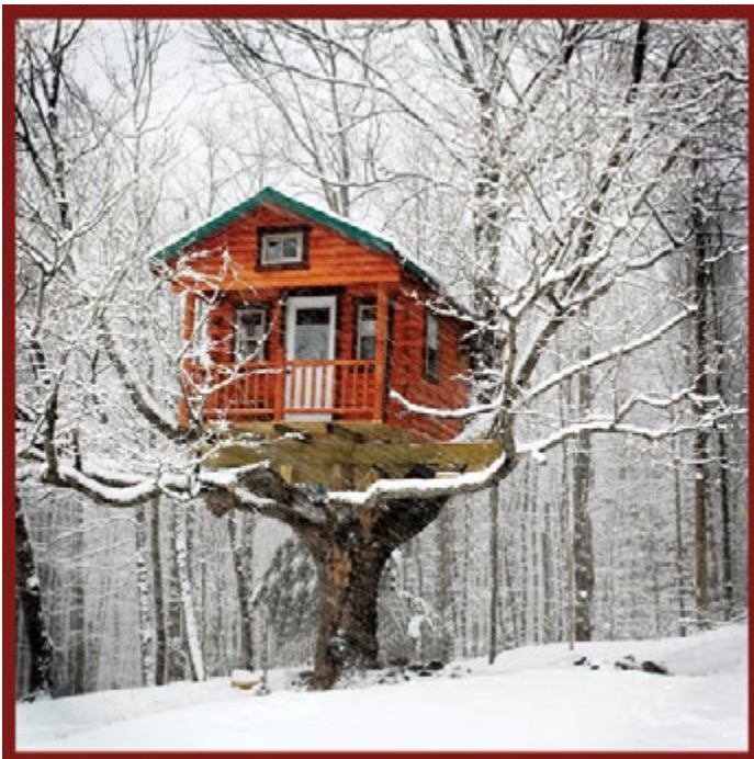
119 La cabane perchée Treehouse
