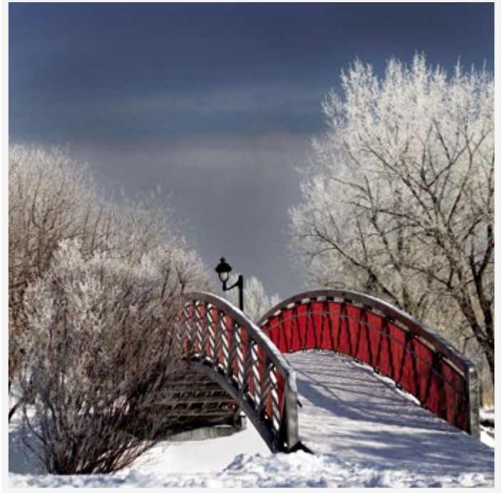
Le pontceau enneigé The snowy little bridge
